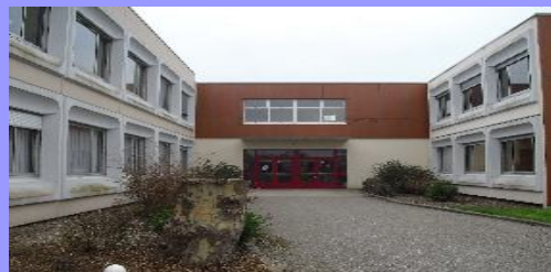
Entrée du lycée de Sauxmarais
